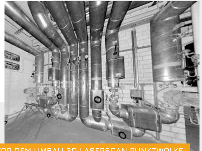
VOR DEM UMBAU 3D-LASERSCAN PUNKTWOLKE
